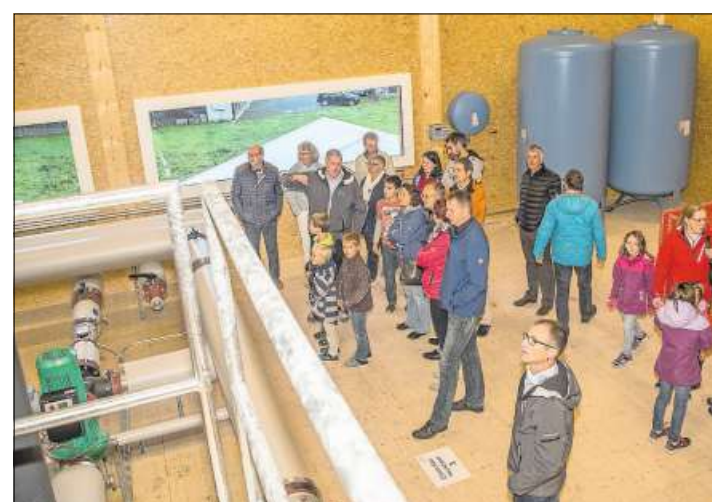
Besucher machen sich ein Bild vom neuen Heizwerk.
